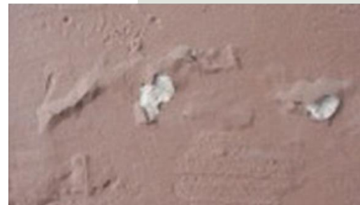
SPALLING
